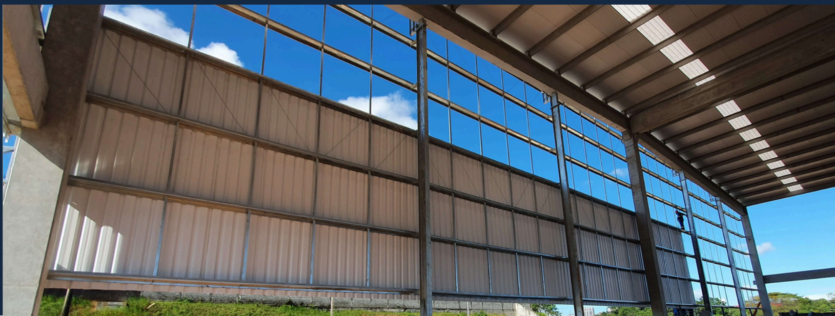
TERÇA Z (Comprimentos conforme projeto)
